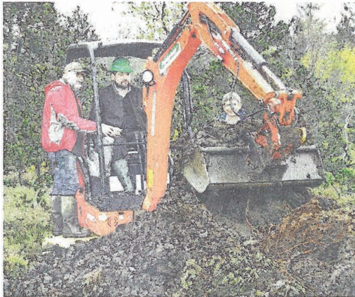
Jörg Edelmann von Garten- und Landschaftsbau Edelmann aus Isny gibt Forstminister Alexander Bonde eine kleine Anleitung, wie er mit dem Bagger die erste Schaufel voll Erde zur Renaturierungsmaßnahme beitragen kann.
